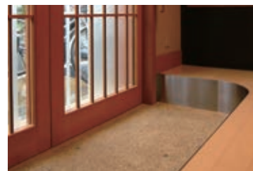
京都府京都市/店舗 かきおとし仕上げ/色名:黄土 設計:設計工房TACtac
