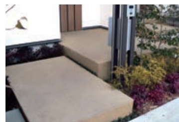
東京都東村山市/個人邸 かきおとし仕上げ/色名:黄土 設計:野沢正光建築工房+半田雅俊設計事務所 施工:相羽建設
